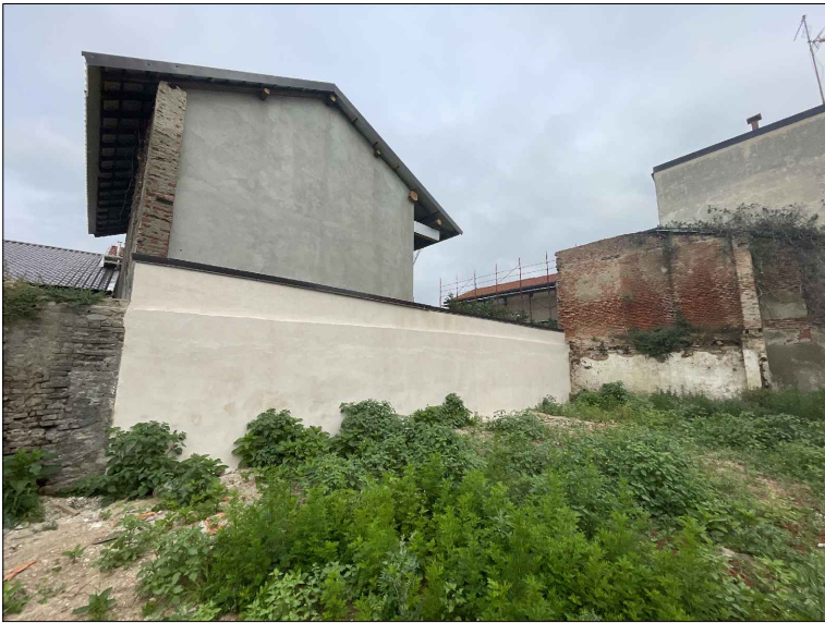
4 Parte delle facciate demolite ricalificate, depositi di macerie ricoperti di vegetazione spontanea
