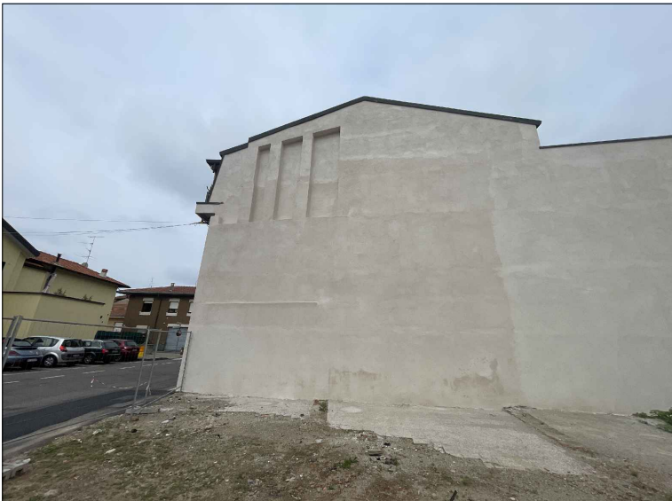
2 Facciata ricalificata dell'edificio all'ingresso - lato ovest
