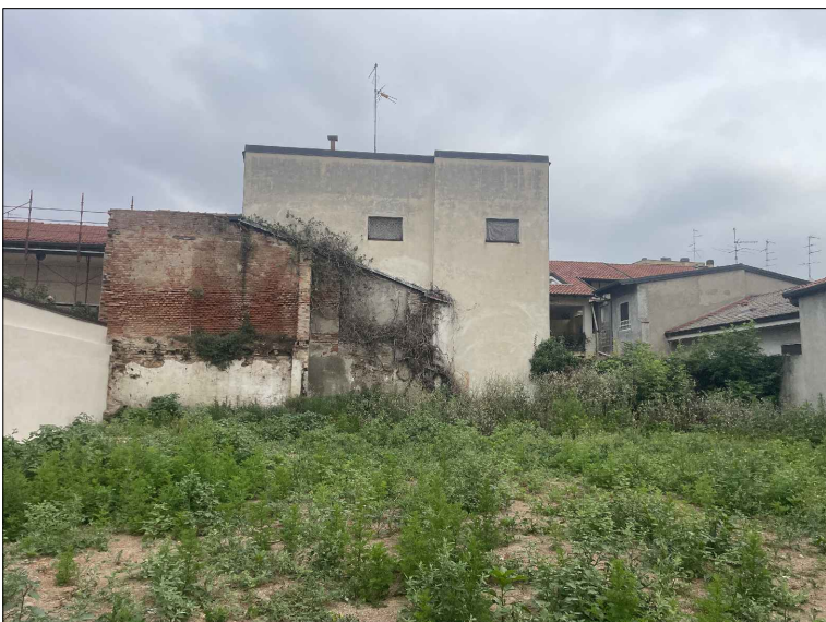
5 Vista del lato nord dell'area di progetto
